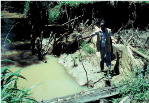
Bild 6: Durch Elefanten zerstörter Erddamm im Burguret River
