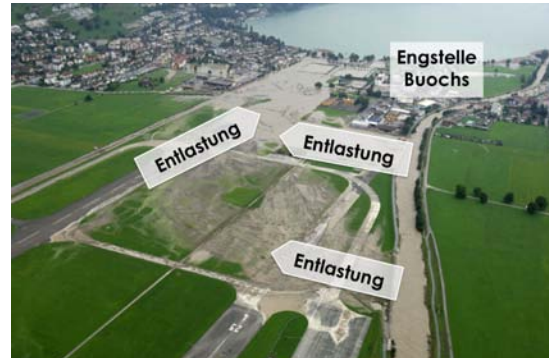
Entlastungen der Engelberger Aa während dem Hochwasser 2005 (Bild: UVEK 2008)
