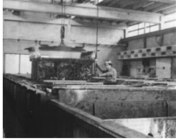
Abb. 3: Elektrolytische Entzinnung
