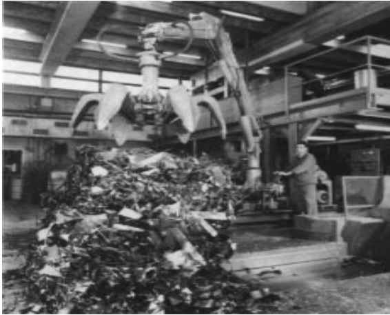
Abb. 6: Verpressung des «Schwarzblechs»
