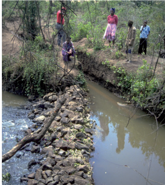
Abb. 8: Durch Elefanten zerstörter Erddamm eines Bauern im Unterlauf des Burguret Rivers südlich von Nanyuki. Die Tiere nahmen in dem aufgestauten Wasser ein Bad. Der Stecken zeigt den Fussabdruck eines der Elefanten.
